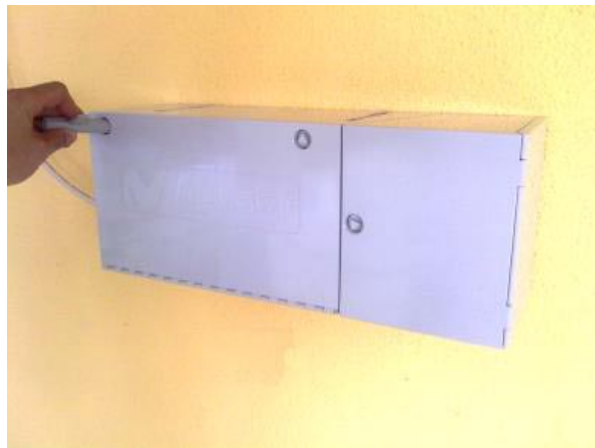
Imagen 3.8. Detalle exterior cerrada de CTO Interior
