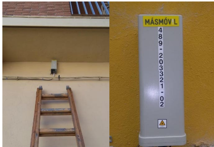
Imagen 1.9. CTO Multipuerto Exterior. Ubicación en fachada y detalle.
