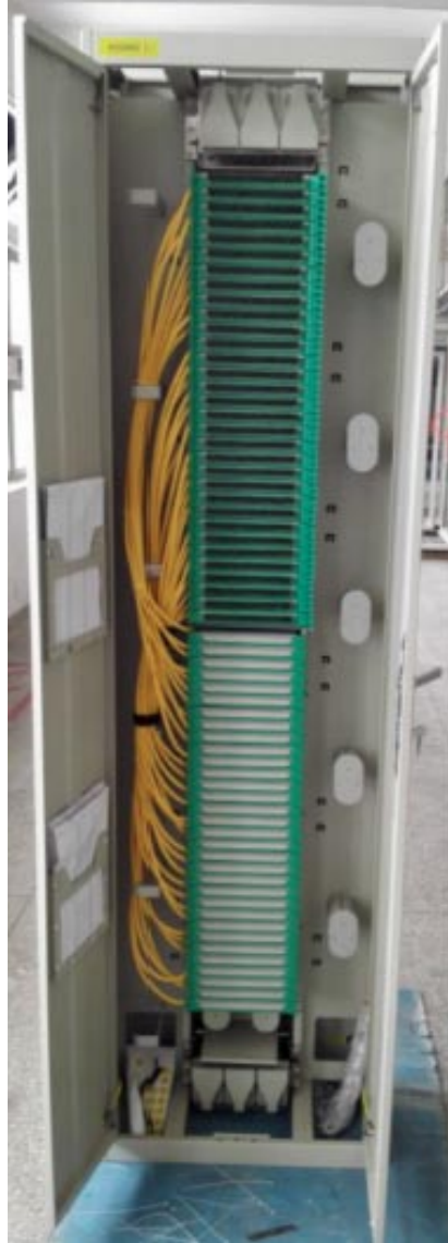
Imagen 3.1: Izquierda Armario ODF
