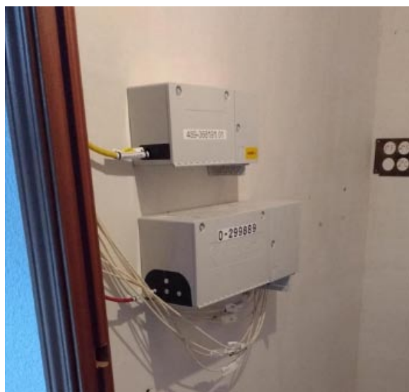
Imagen 1.9. CTO interior. Ubicación en cuarto telecomunicaciones
