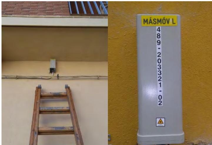
Imagen 1.9. CTO Multipuerto Exterior. Ubicación en fachada y detalle.
