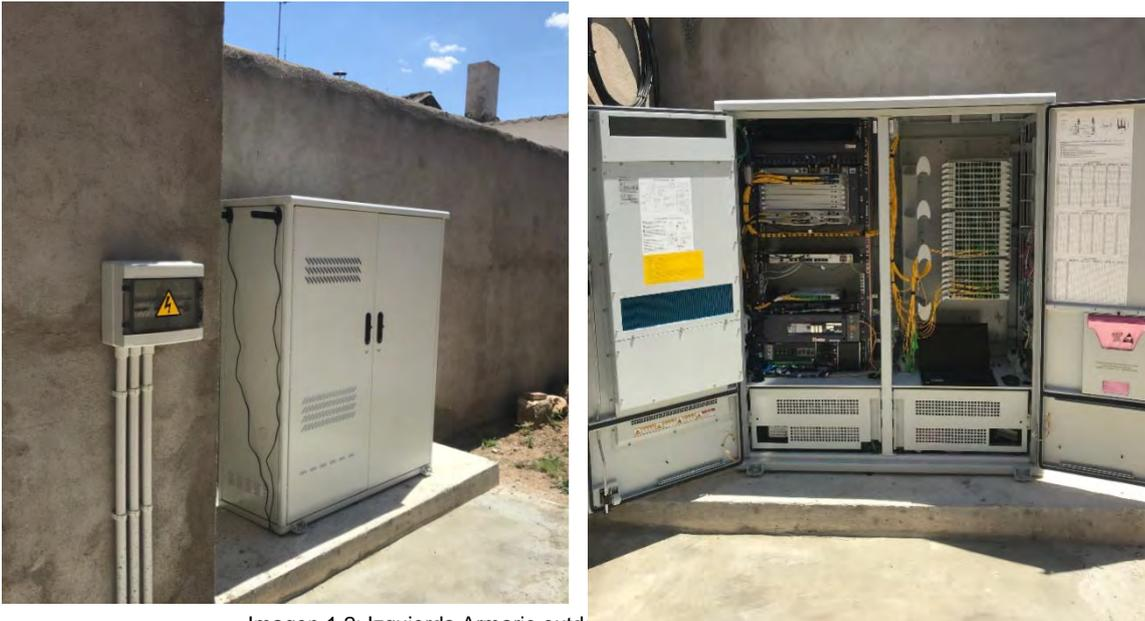
Imagen 1.2: Izquierda Armario outdoor cerrado en banca. Derecha Armario outdoor abierto.
