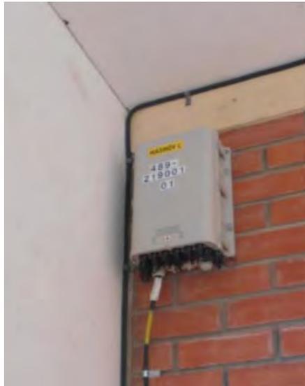
Imagen 1.7. CTO exterior 16P. Ubicación en fachada.y Splitter
