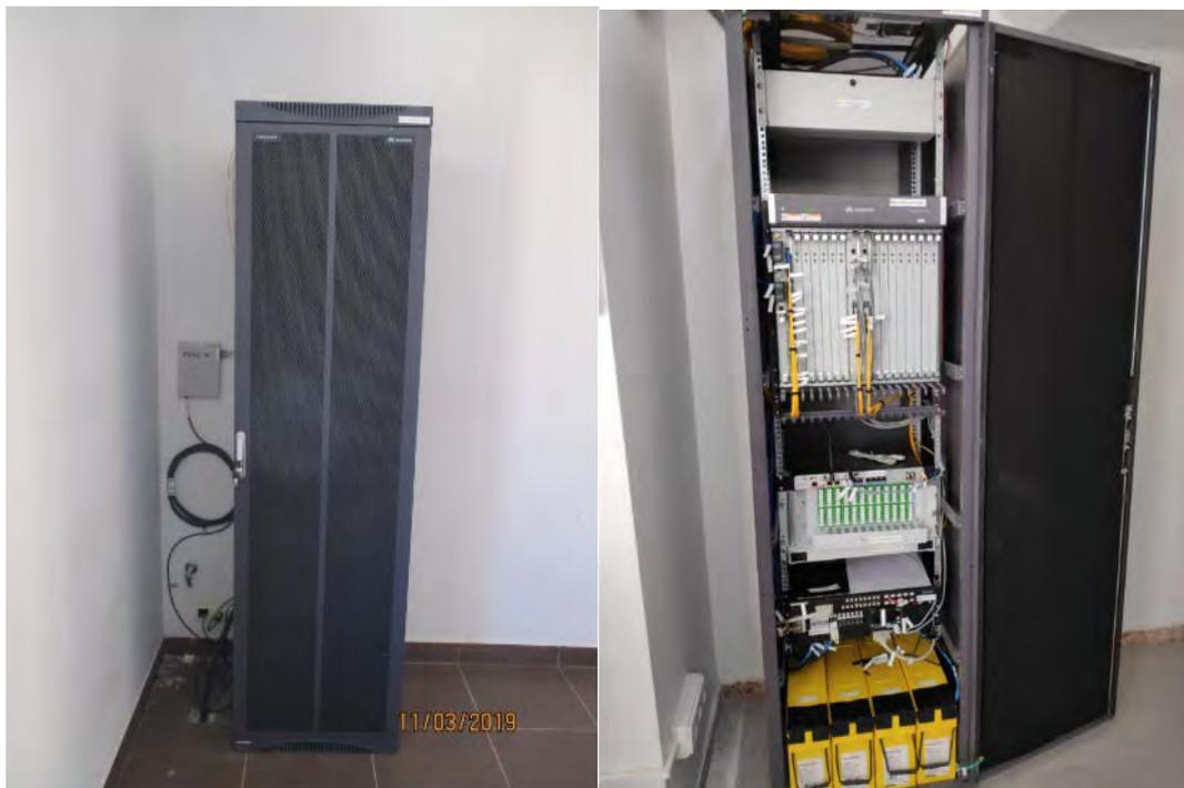
Imagen 1.3: Izquierda Armario indoorcerrado. Derecha Armario indoor abierto.
