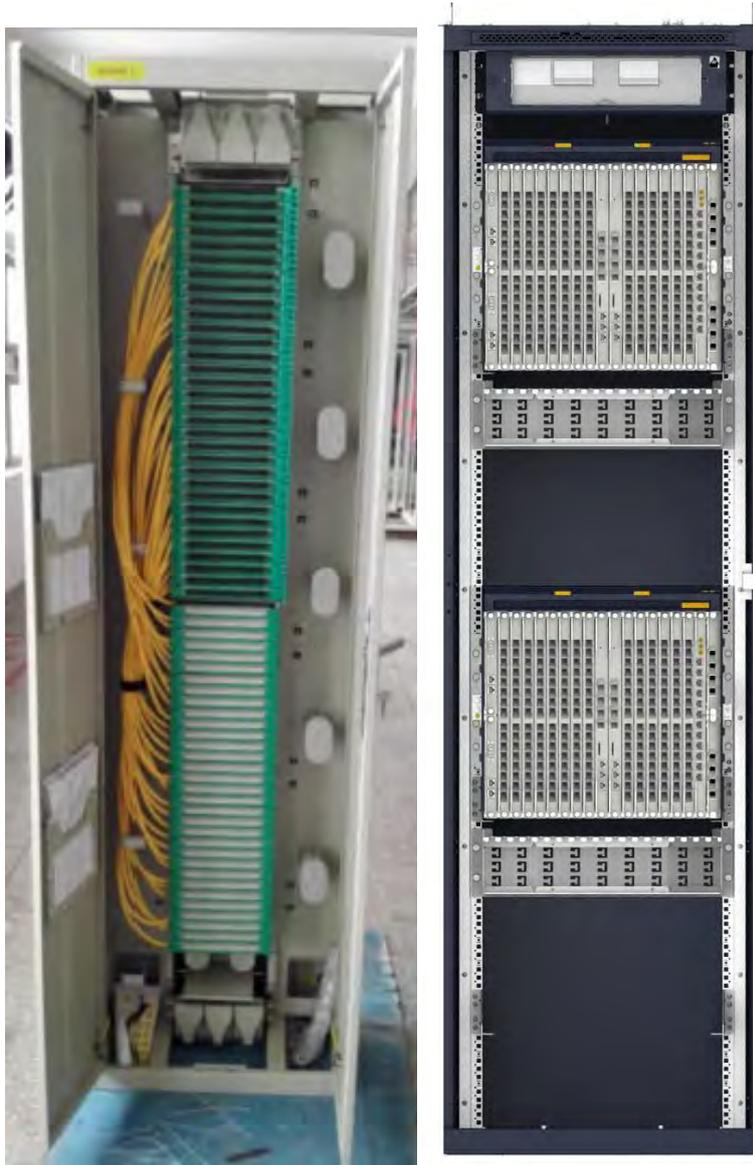
Imagen1.1: Izquierda Armario ODF, derecha armario con OLT
